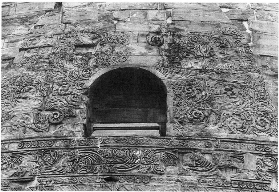
図30 ダメーク大塔外壁
