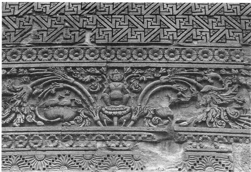
図29 ダメーク大塔外壁
