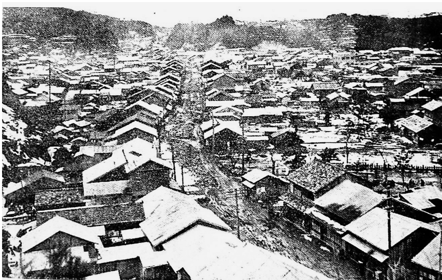
写真4 地震から約1年後の復興状況（昭和3年3月2日、『奥丹後震災誌』）
