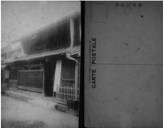
図11 美濃ミッション写真（大垣教会の建物）
