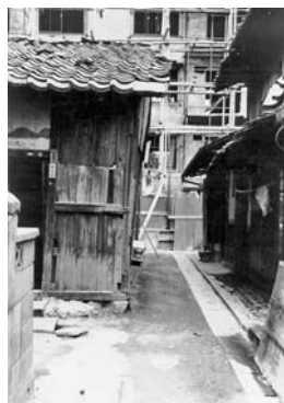
図1 不良・危険住宅と改良住宅建設
